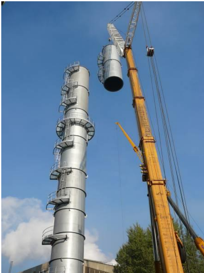
Montaż segmentu komina-poz. +64,5m
