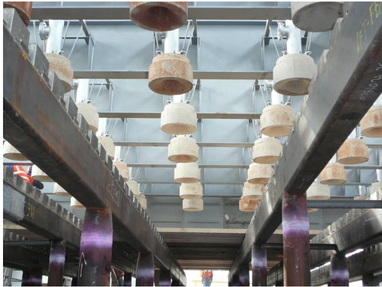
Wnętrze pieca-widok belek rusztu pieca
