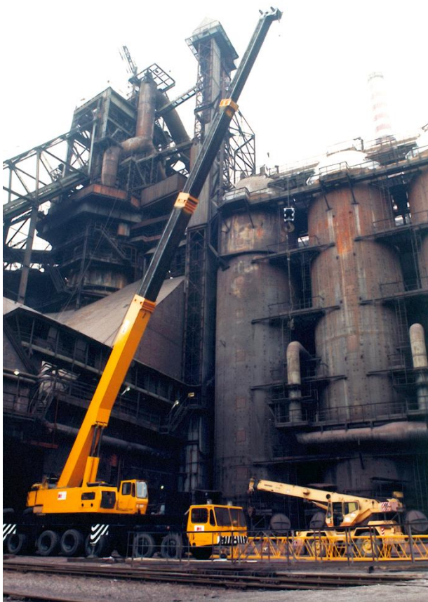
Remont nagrzewnicy WP
